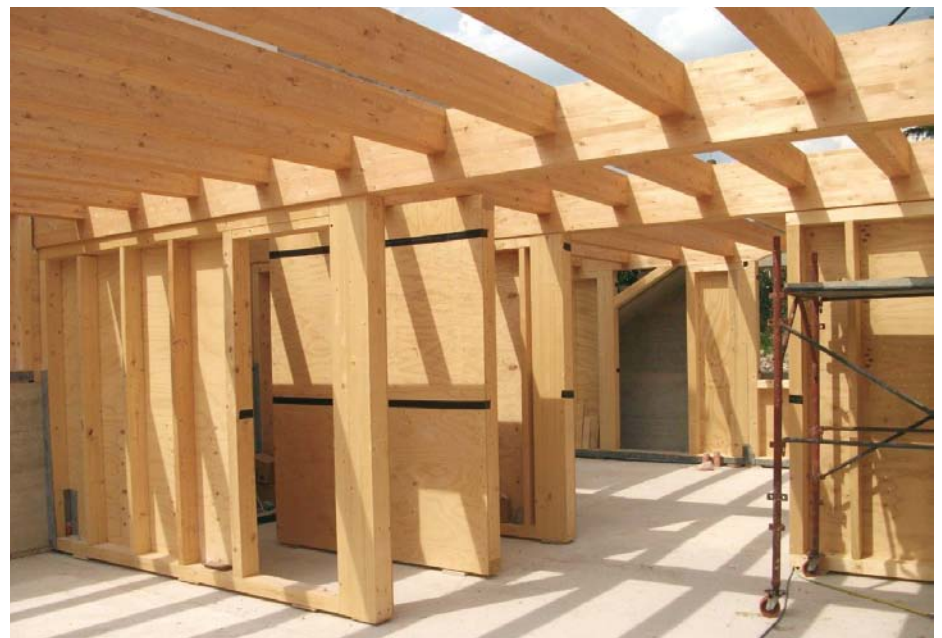
in questa pagina esempi di costruzioni con tipologia X-LAM immagini di cantiere nella fase di assemblaggio dei componenti in legno lamellare
